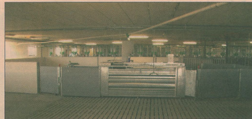
Transponderstation indbygget i stidskillelsen – og således, at søerne forlader stationen ligeud.
